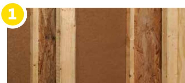
1 Construction de base : structures en bois et ossature bois, par exemple des poutrelles TJI.
