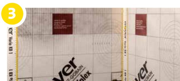
3 Les différents lés de **Vario KM Triplex** se superposent largement (recouvrements de 15 cm minimum). Un autocollant unilatéral **Vario KB1** doit être posé sur les zones agrafées et les raccords entre les lés, afin de renforcer encore l'étanchéité à l'air.
