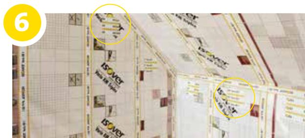
6 Colmatez l'ouverture avec un adhésif **ISOVER Vario KB1 Patch** (16 cm X 16 cm) afin de garantir l'étanchéité à l'air. Placez ensuite les finitions sur des lattes en bois ou des profilés métalliques.
