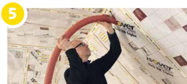
5 Remplissez le vide d'**ISOVER Insulsafe Plus Wood** à une densité de 35 kg/m<sup>3</sup>, tant verticalement qu'horizontalement et en pente.
